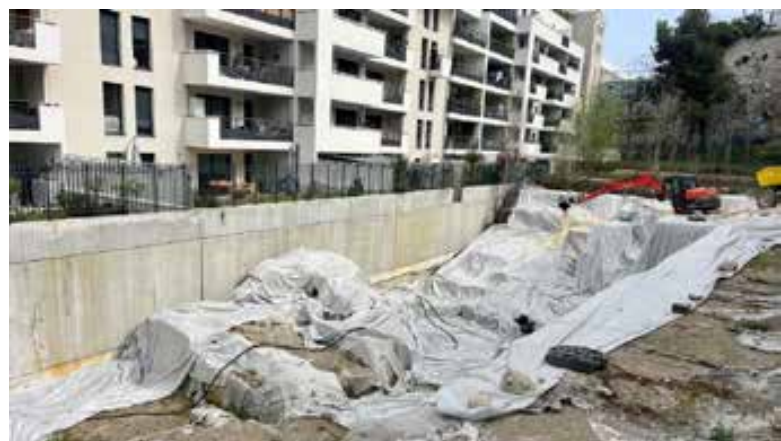
Les travaux d'enfouissement de la carrière antique
