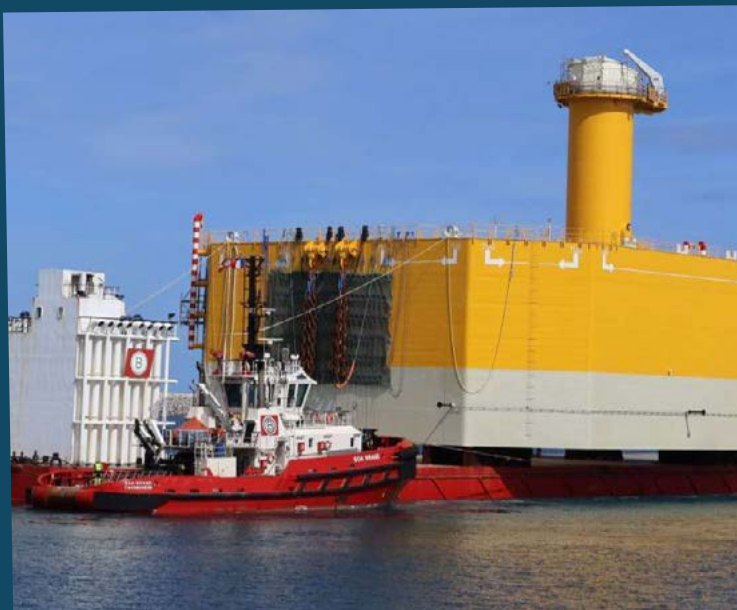
Les deuxième et troisième flotteurs de conception BW Ideol, assemblés par MP ArchiMed, ont été mis à l'eau coup sur coup à Port-La Nouvelle. ©Eolmed
