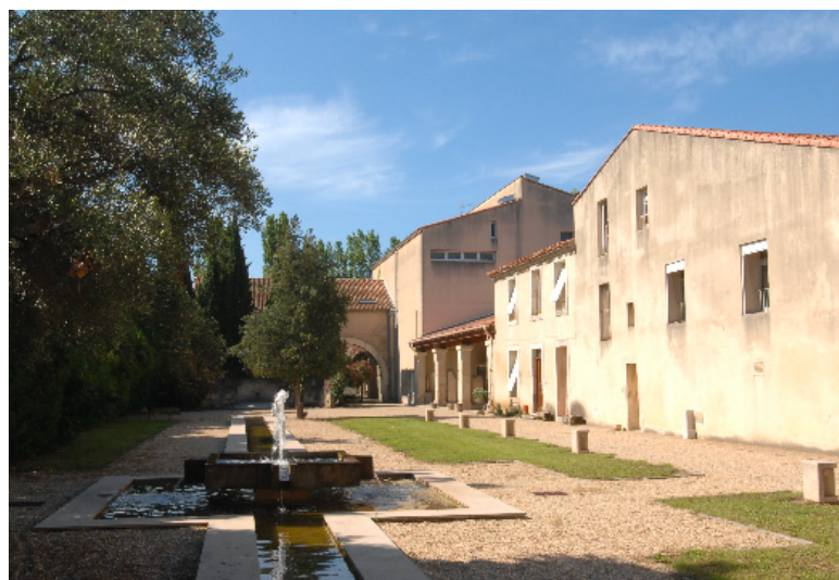
Vue extérieure - © Montpellier agglomération
